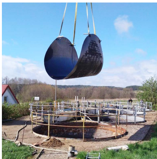
Prace montażowe w ramach uszczelnienia zbiornika wykładziną chemoodporną
