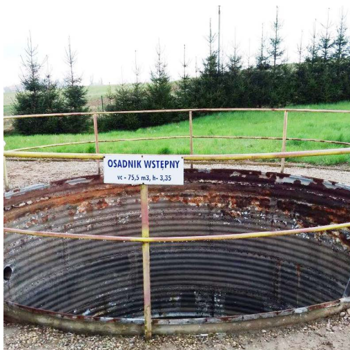
Stan stalowego osadnika wstępnego przed uszczelnieniem
