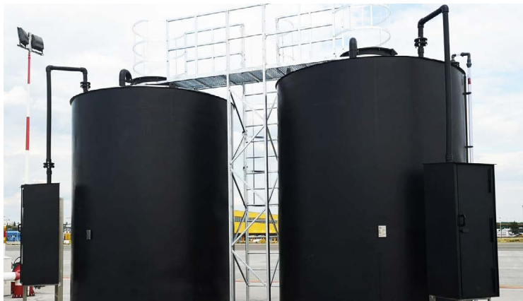
Zbiorniki z PE100 po 24 m 3 każdy do magazynowania płynu clariant
