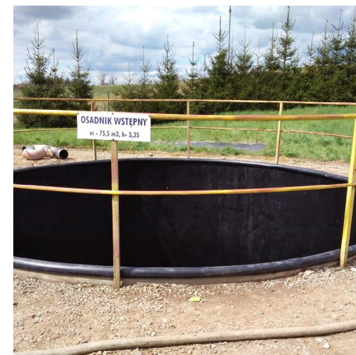
Stan osadnika po wykonaniu renowacji za pomocą wkładu z tworzywa sztawnego
